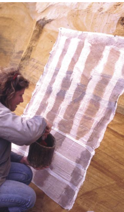
Abb. 2: Die vorverfestigte Oberfläche wird nun mit Mullgaze und unverdünntem Lack verbunden und befestigt. Manchmal streicht den Lack dabei zuerst lieber in Streifen...
